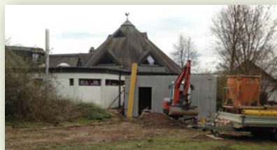
Anbau des Pelletlagers am Paul-Gerhardt-Haus
